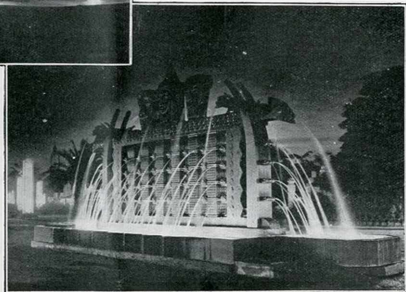
Fig. 8. — Les Totems (en bas). Architectes : Granet et Expert. Eclairage : Paz et Silva.
